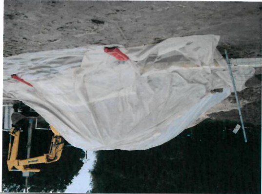
Stockage des terres impactées sous polyane
