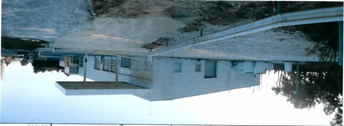
Stockage des terres impactées sous polyane
